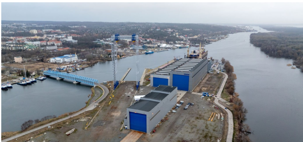
Rysunek 15. Montownia gondol Vestas w Szczecinie
